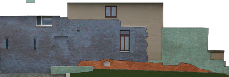
Farbige Markierung der Altersstruktur im Sichtmauerwerk der Nordwand
