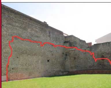
Aula regia, innen, Apsis und Ostwand, Markierung Trennlinie karolingisches Mauerwerk
