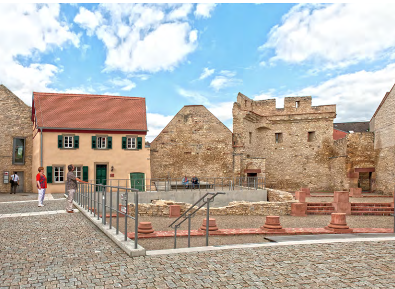
Der Denkmalbereich „Heidesheimer Tor“
