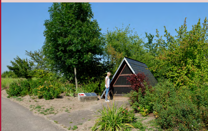
Teilstück der Wasserleitung unter einem Schutzdach
