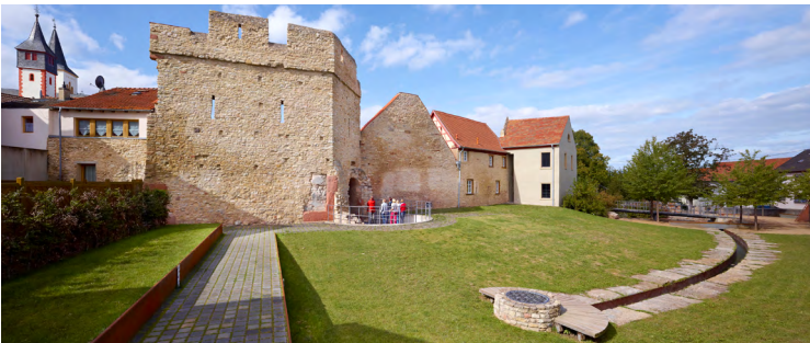
Außenfassade des Heidesheimer Tors
