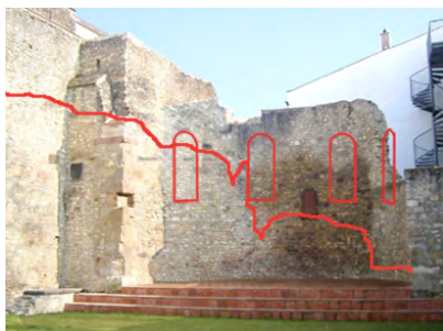
Aula regia, Apsis Markierung Fensteröffnungen und Trennlinie karolingisches Mauerwerk
