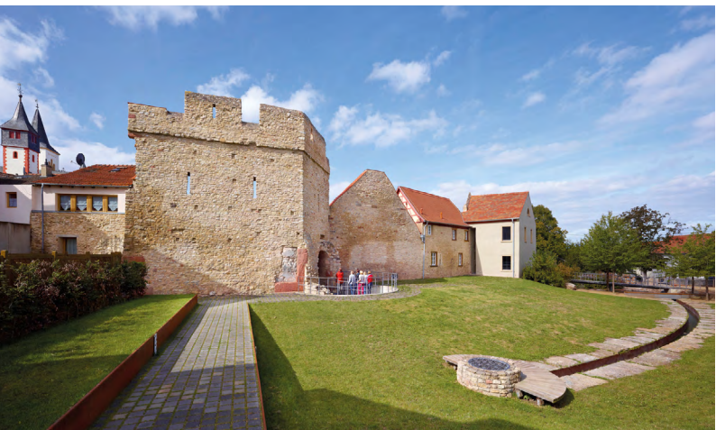
Außenfassade des Heidesheimer Tors
