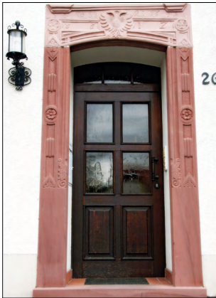
Portal der alten Schaffnerei, verbaut am Zuckerberg 26
